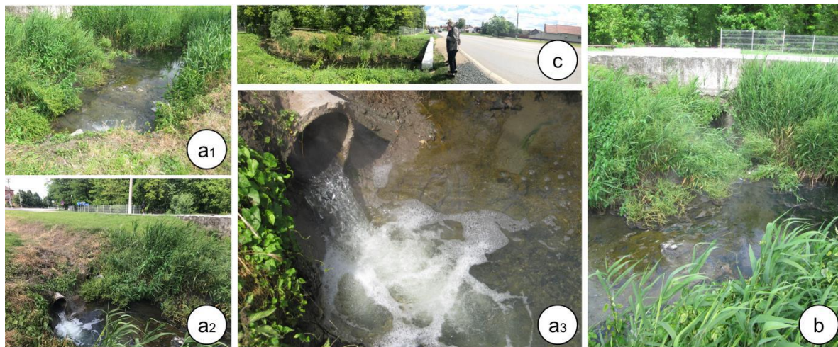
Ilustrația 17: scurgerea apei termale în șanțul de drenaj (a1, a2). La punctul de evacuare a unei conducte din beton (a3) a urmat determinarea temperaturii apei aburinde ( 62^{\circ}\text{C} la temperatura aerului de 19^{\circ}\text{C} , ceea ce corespunde unei puteri de 1\text{ MW}_{\text{th}} la 6\text{ l/s} ). (b) indică trecerea sub stradă (Düker) și (c) continuarea șanțului de drenaj pe partea nordică a străzii în interiorul parcului.
