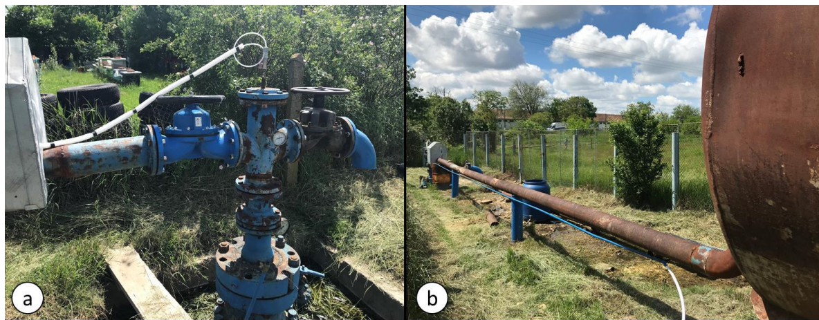
Ilustrația 7 (a): puțul de producție nr. 4607 precum și (b) conducta de alimentare de la puț la degazeificator
