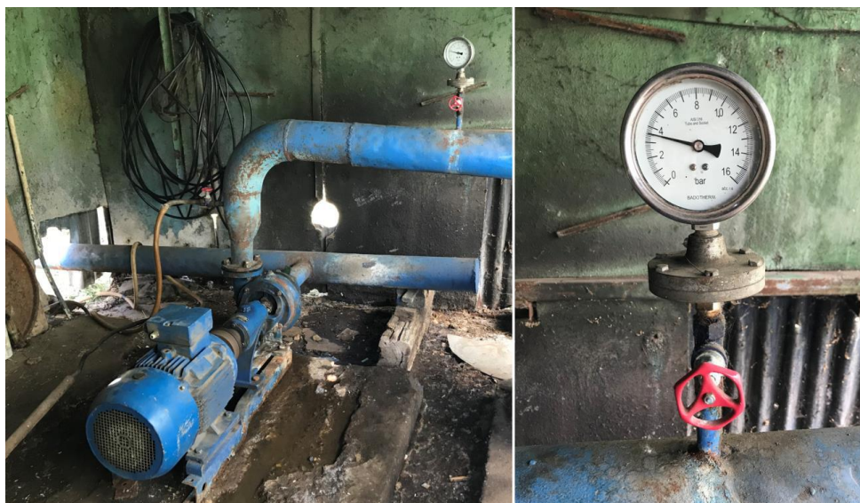
Ilustrația 10: pompă supraterană pentru creșterea presiunii în conducta de apă termală.
