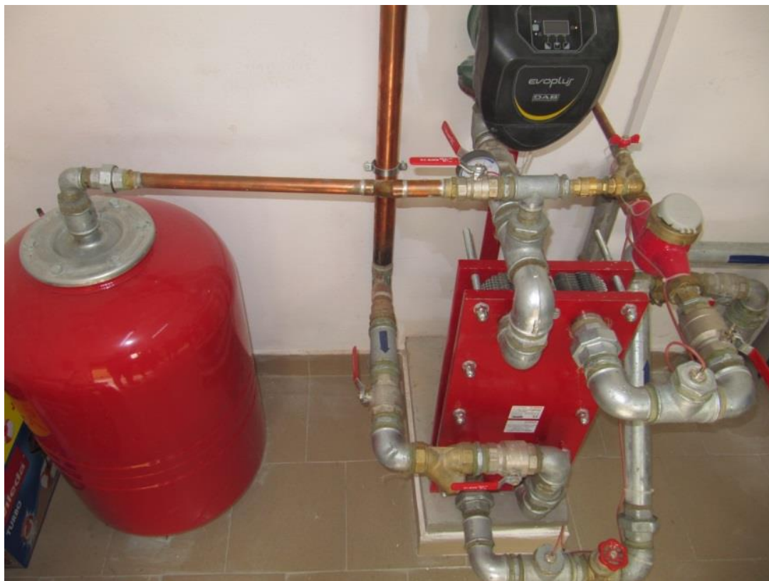
Ilustrația 15: schimbător de căldură în plăci cu rezervor de compensare a presiunii pentru alimentarea unei construcții noi în Lovrin
